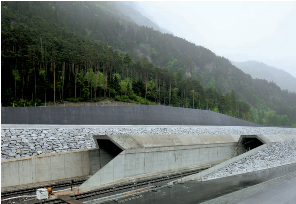
Dynamischer Beton inszeniert beim nördlichen Portalbereich den Verkehr, Granit erinnert an die alte Gotthardbahn.
