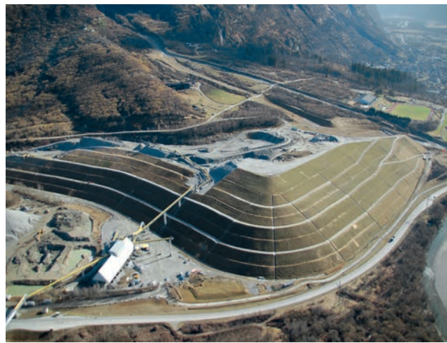
6,6 Millionen Kubikmeter ausgebohrtes Gestein bilden bei der Buzza di Biasca einen künstlichen Berg. Foto: Alptransit Gotthard
