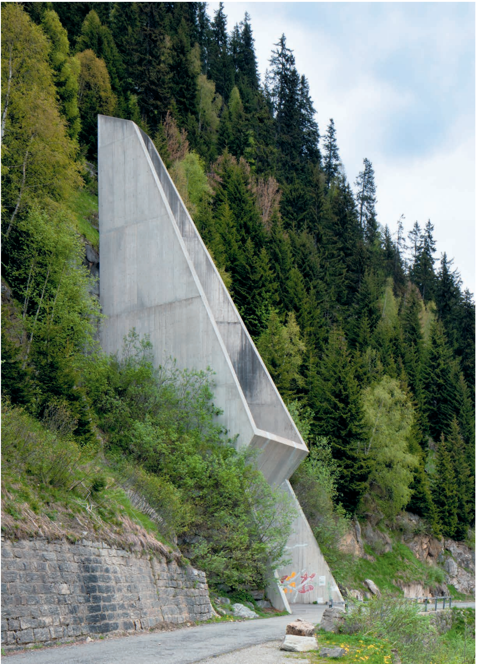
Entlüftung, Wendeplatz, Lawinen- und Steinschlagschutz verbinden sich in der Val Nalps zur expressiven Betonplastik.
