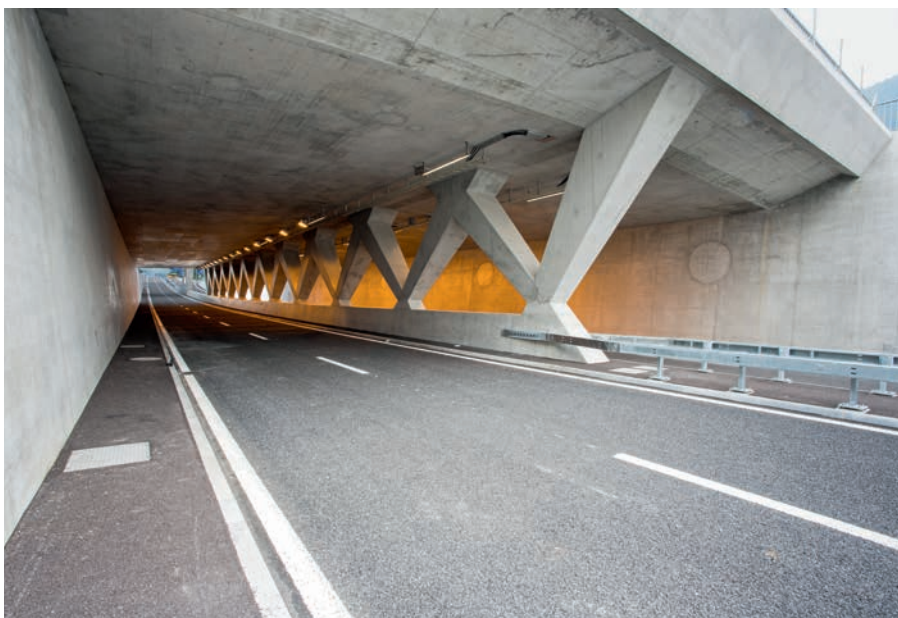
Bei etwa 150 Nebenbauten, Brücken und Unterführungen sorgen wiederkehrende Details wie dieser Konsolenkopf der Unterführung in Camorino für gestalterische Kohärenz. Foto: CIPM / Franco Banfi
