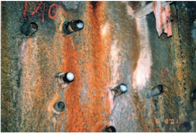
Fig. 8-10, oben: Doppelbohrinstallation im Basistunnel; unten: ausinjizierte Bohrungen (ZLS, Sm 108).
