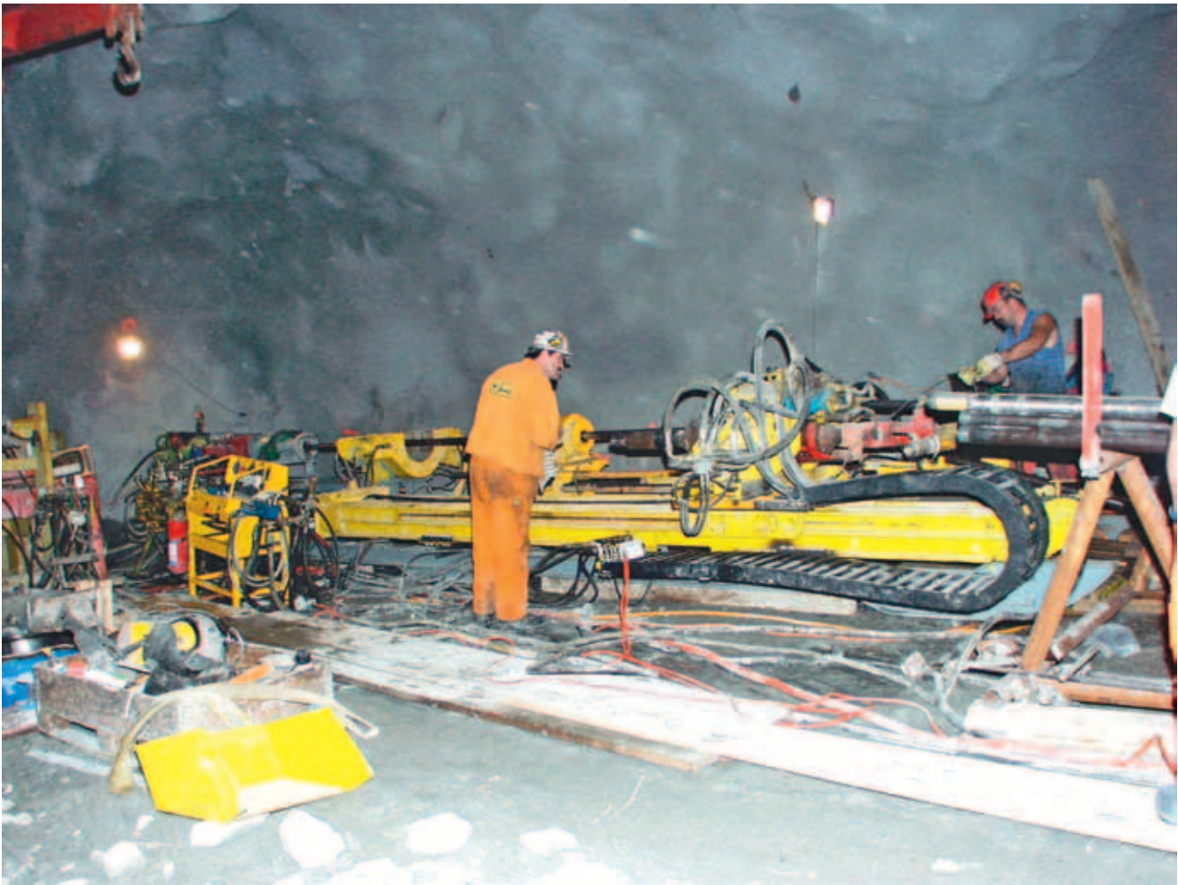
Fig. 7-4: Zur Erkundung des Jungfraukeils eingesetzte Untertagebohranlage der Firma Stump Foratec SA.
