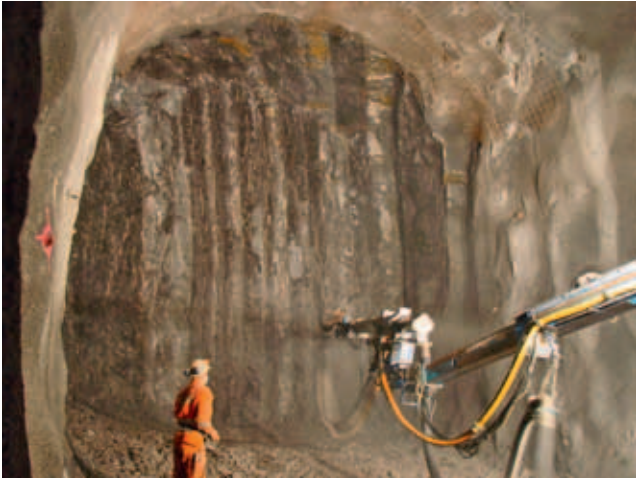
Fig. 3-1: Steilstehende Taveyannaz-Serie (Oströhre km 15,017).
