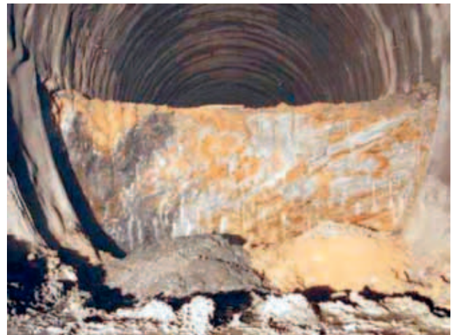
Fig. 8-14, oben: Kalottenvortrieb bei km 48,480; unten: Stross- und Sohlenabbau bei km 48,481 (Oströhre).
