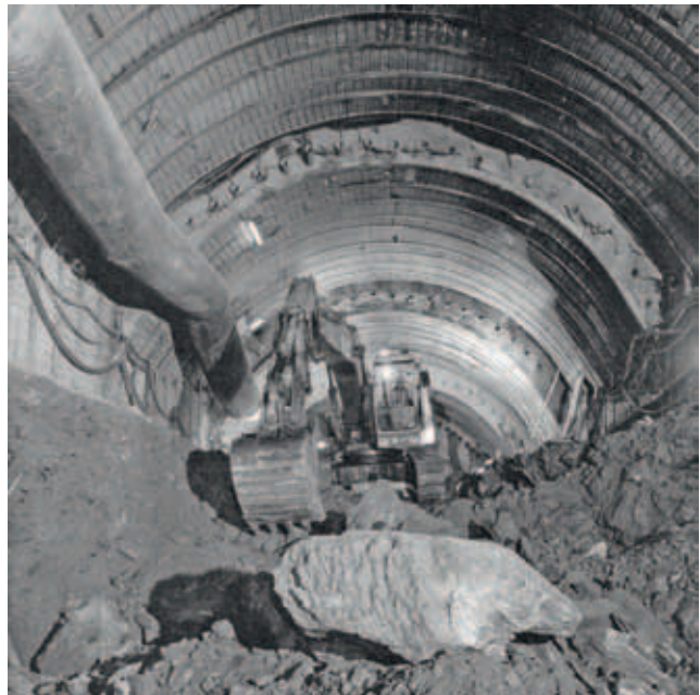
Fig. 8-2: Vortrieb im Schutz eines Rohrschirmes (Unterquerung der BLS-Bergstrecke beim Portal Frutigen).
