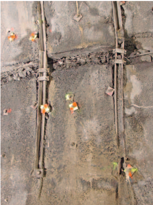
Fig. 5-4: Verbogene Stahlbögen im Karbon (Oströhre km 30,421).
