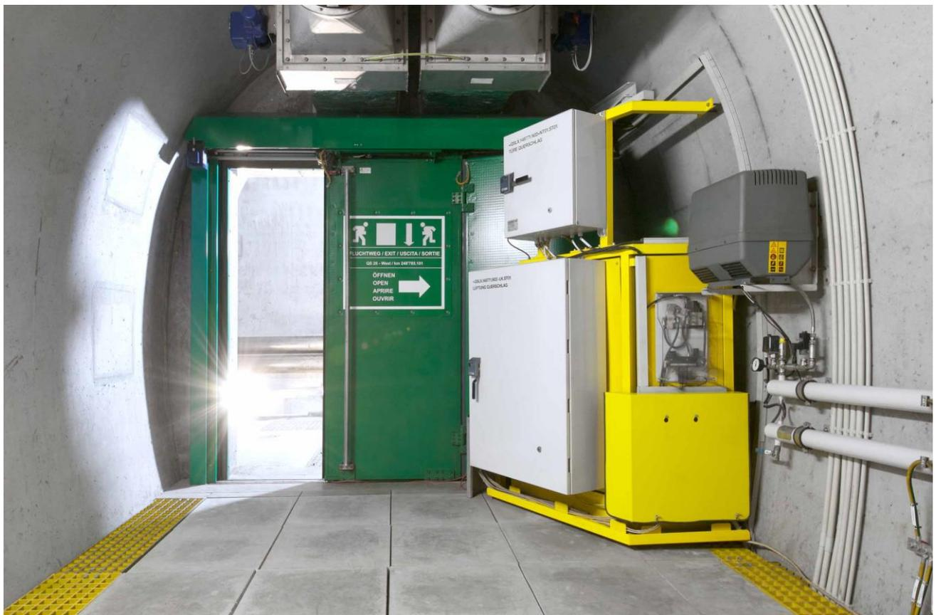
Bild 1: Türansicht aus dem Inneren des Querschlages (Türe halb geöffnet grün, Antrieb hinter oberen grünen Abdeckung, gelber Schutzzaun der den Schwenkbereich absichert, grau: Steuerschränke für Türen und Querschlaglüftung, schwarz: Kompressor für pneumatische Blähdichtung)
