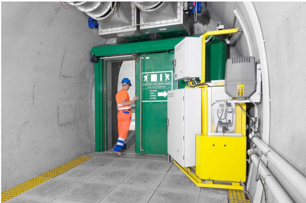
Bild 5: Türe im halbgeöffneten Zustand mit vertikaler Haltestange zum Öffnen der Türe (Auslösung des Unterstützungsantriebes oder Handbetrieb)
