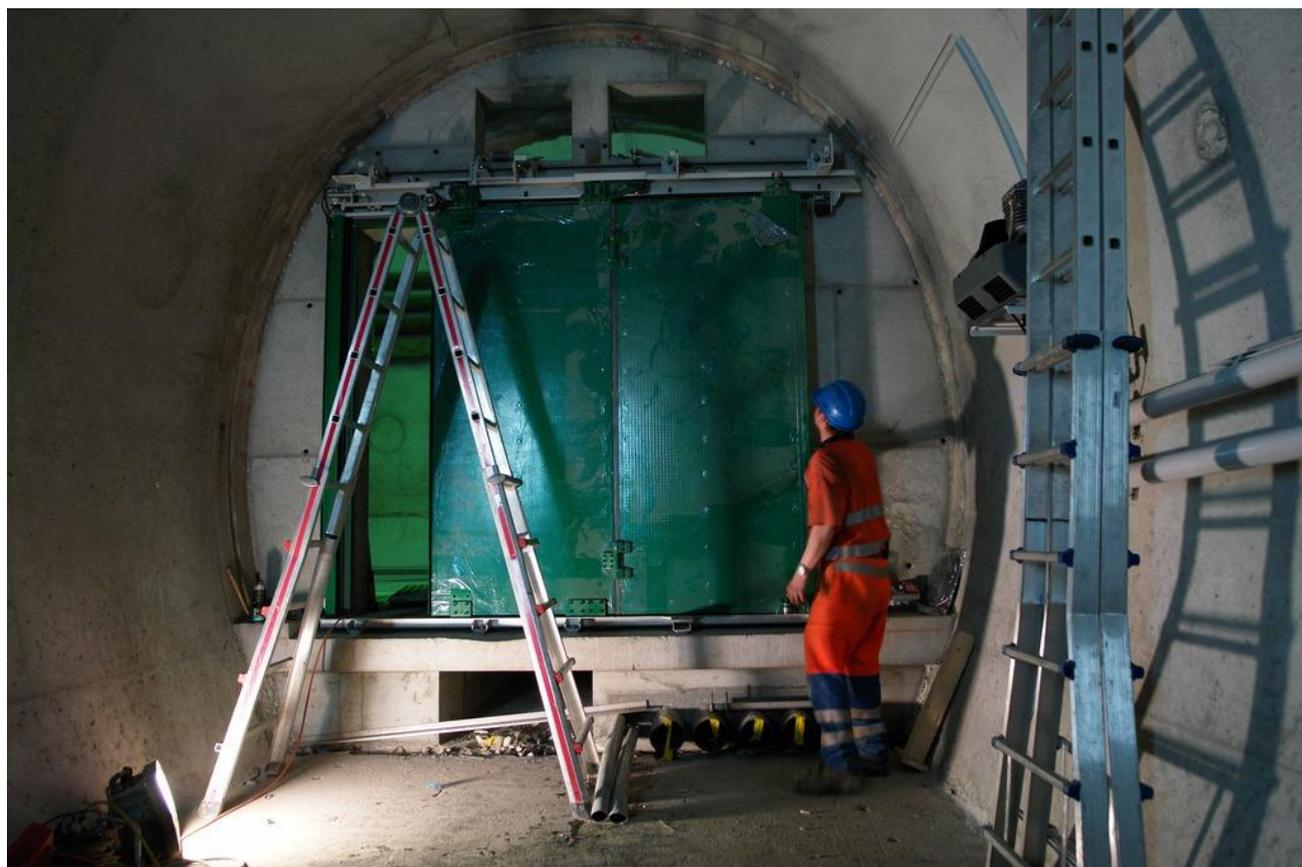
Bild 4: Einbau einer Querschlagtüre
