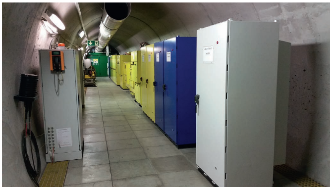
Bild 13 Ausrüstung eines Querschlags am GBT (Bild T. Jesel, Ingenieurgemeinschaft GBT Süd)
