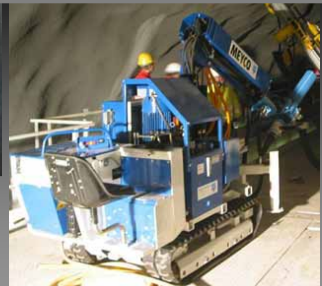
Mobiles Spritzbetongerät im L1 "Oberdeck"
