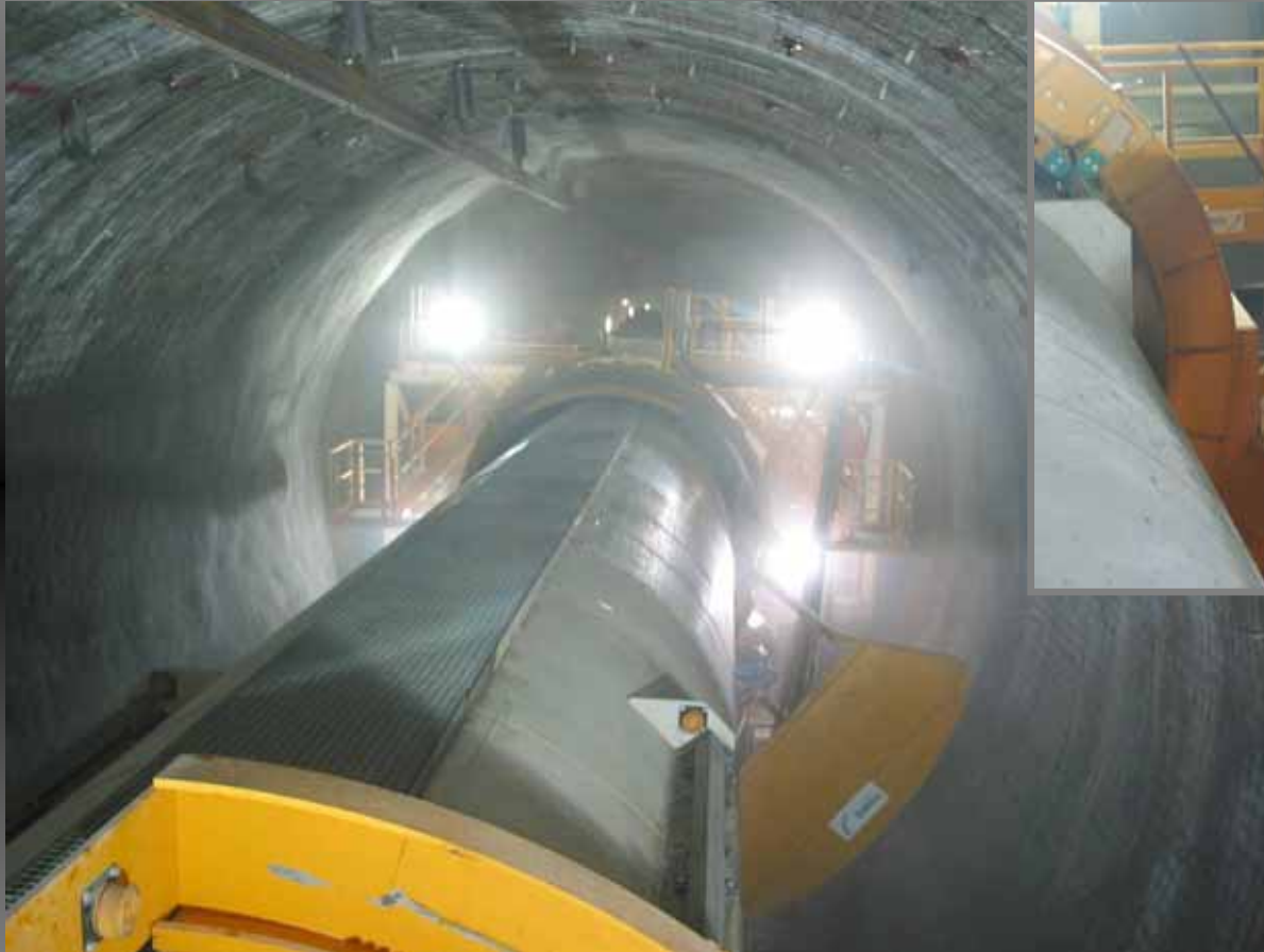
Spritzbetonroboter im Bereich L2
