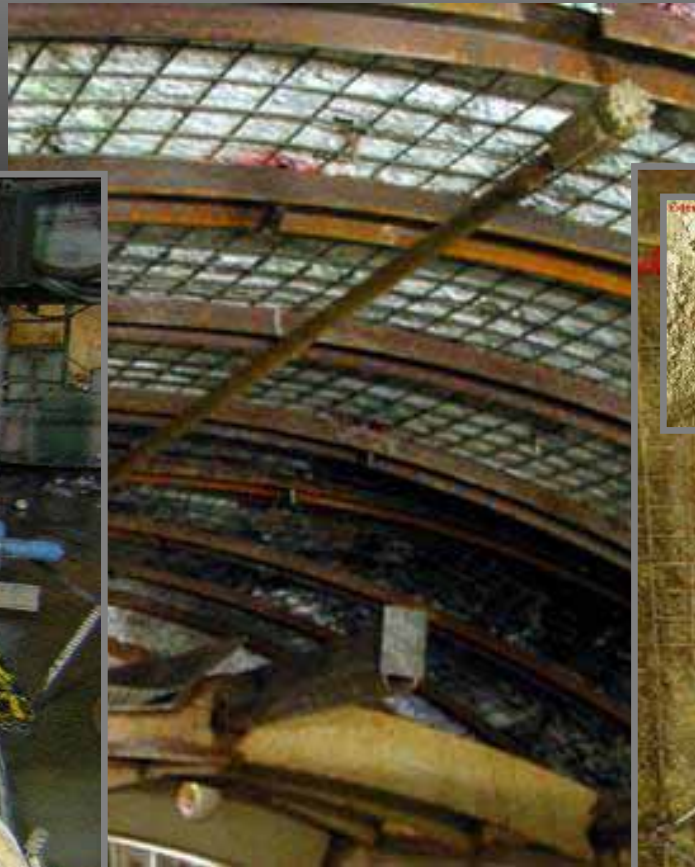
Drehschlagbohrung Ø 76 mm
