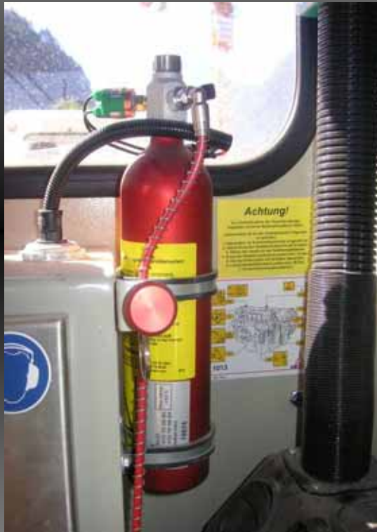
Installation im Führerstand der Schöma-Lokomotiven
