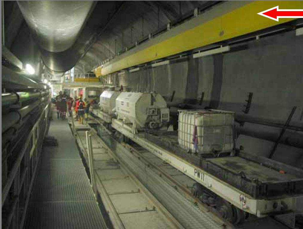
Spritzbeton Containertransport / Umschlagbahnhof
