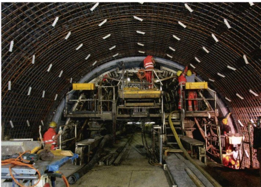
In der Oströhre wird der letzte Bewehrungsblock der Multifunktionsstelle installiert.
