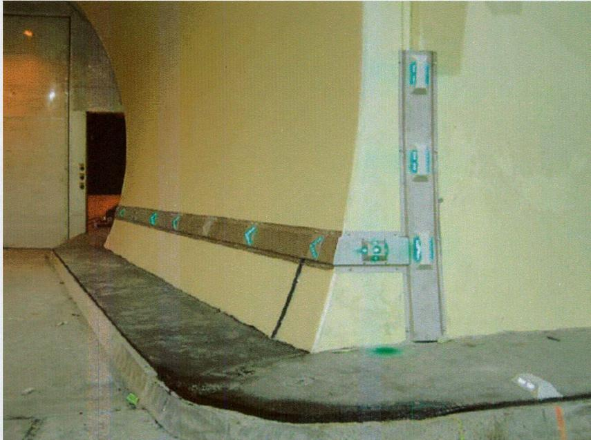
Abbildung 30: Dynamische Fluchtwegkennzeichnung und Fluchttürkennzeichnung (Tunnel Strengen, Österreich)
