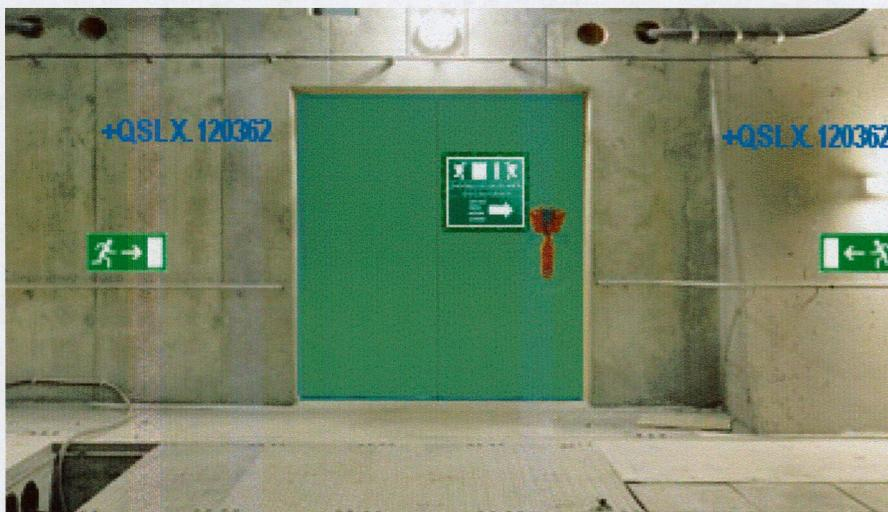
Abbildung 16: Mögliche Gestaltung und Beschilderung des Bereiches der QS-Türen (Basis QS LBT, Fluchtwegschild auf QS-Türe Basis [5])
