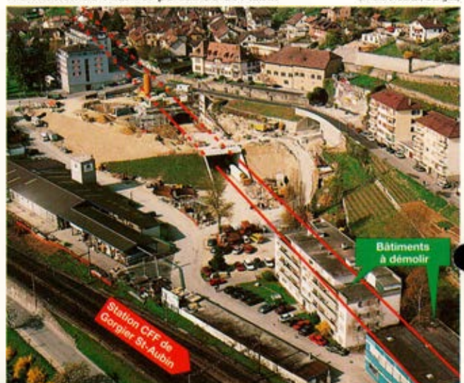
Installation de chantier portail de St-Aubin (Photo J. Jeker, Denges)
