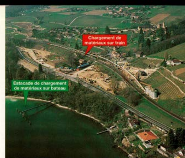
Vaumarcus: Evacuation des matériaux
