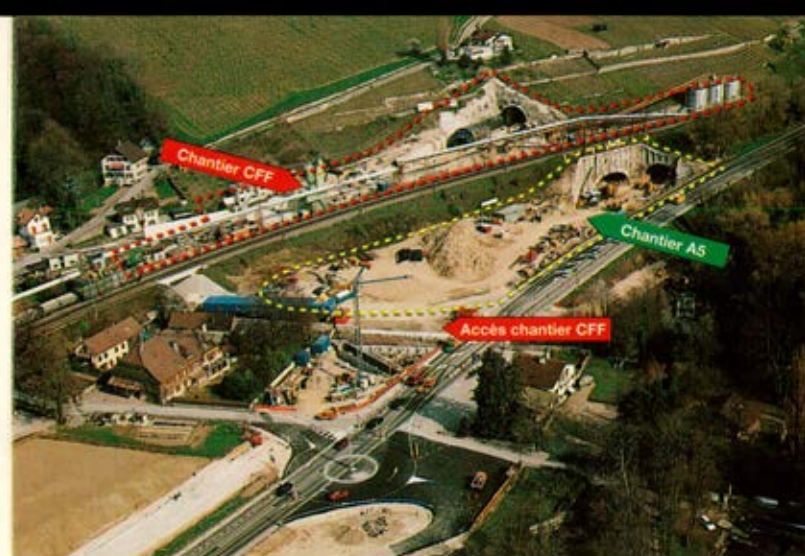
Installation de chantier portail de Vaumarcus (Photo J. Jeker, Denges)
